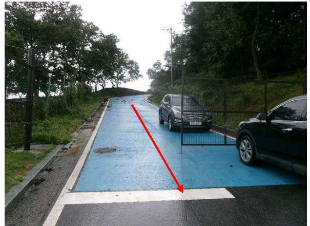
<송수관로 (Sta.17+1.5) 포장 및 지반 상태양호>
