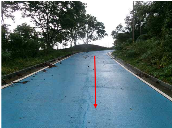
<송수관로 (Sta.14+15.8) 포장 및 지반 상태양호>
