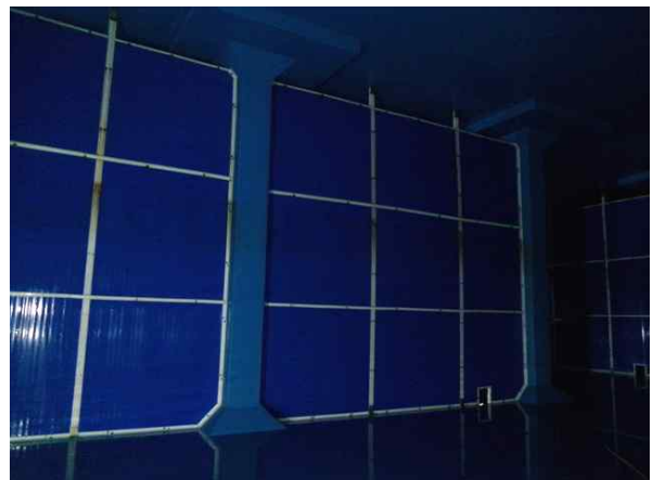
<배수지 2지 도류벽 상태양호>
