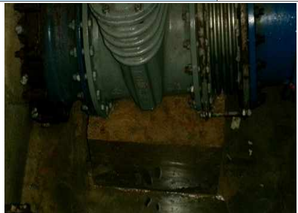
<송수관로 Sta.4+0.0(유량계실) 기초 상태양호>
