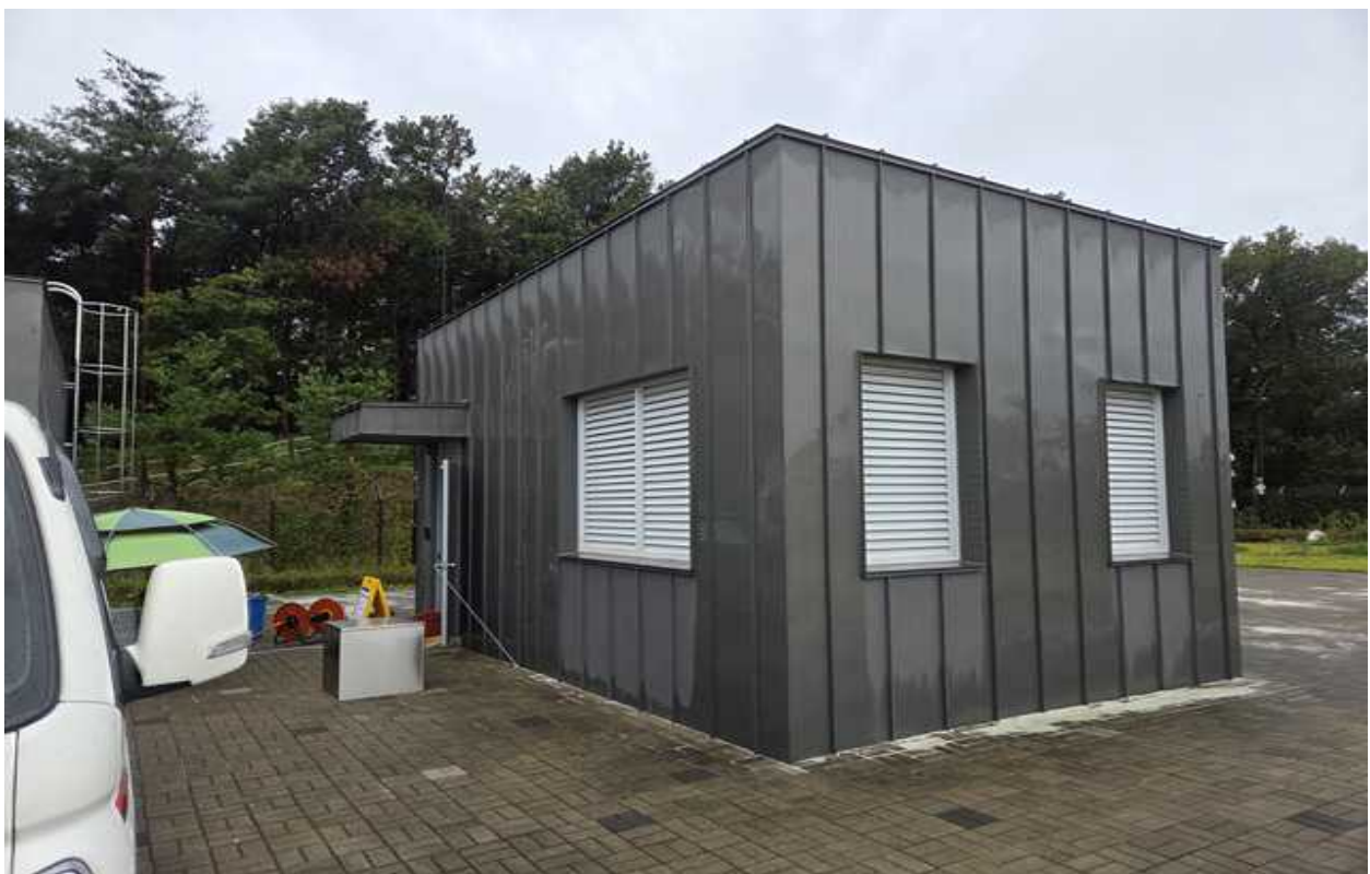
<화성비봉 공공주택지구 밖 배수지 및 진입도로 중 배수지 및 송수관로(배수지)>
