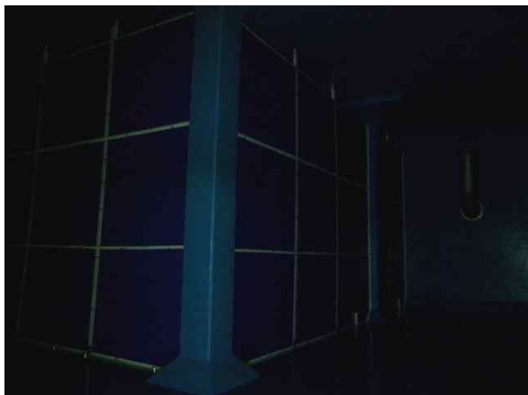
<배수지 1지 기둥 상태양호>
