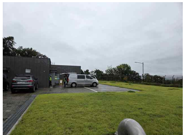
<배수지 상부 전경>
