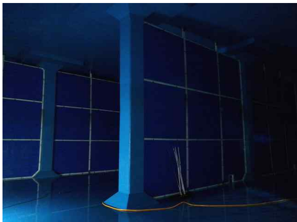
<배수지 2지 기둥 상태양호>
