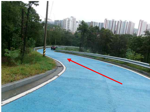
<송수관로 (Sta.4+0.0) 포장 및 지반 상태양호>
