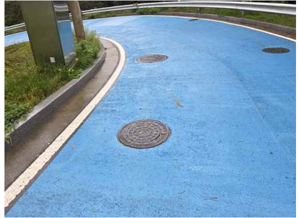
<송수관로 점검구(B1-1) 맨홀 덮개 상태양호>
