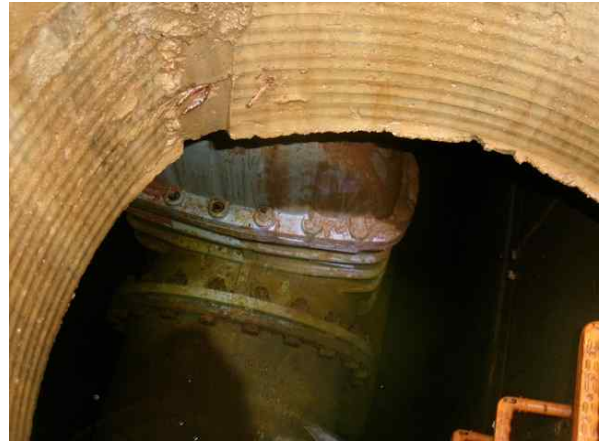
<송수관로 Sta.17+1.5(점검구) 도장 상태양호>
