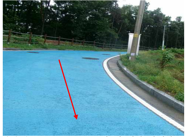
<송수관로 (Sta.3+16.1) 포장 및 지반 상태양호>
