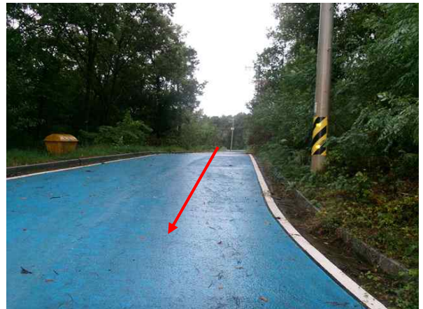
<송수관로 (Sta.7+16.7) 포장 및 지반 상태양호>
