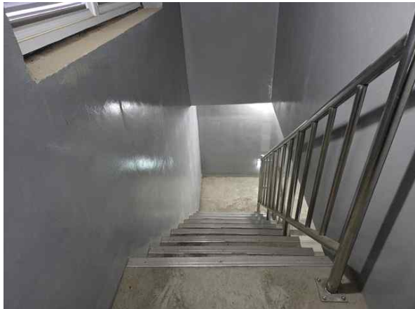
<계단실 내부 전경>
