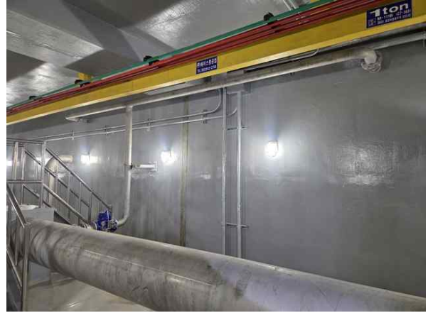
<유입밸브실 벽체 상태양호>
