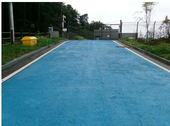
<송수관로 Sta.3+16.1 포장 상태양호>
