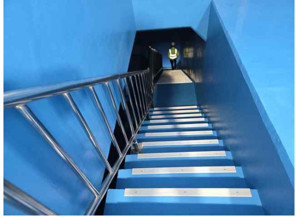
<내부 개별부재 외관조사>
