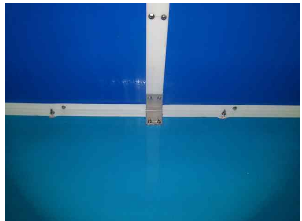
<배수지 2지 도류벽 볼트체결 상태양호>
