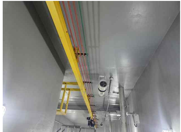
<유출밸브실 상부슬래브 상태양호 >
