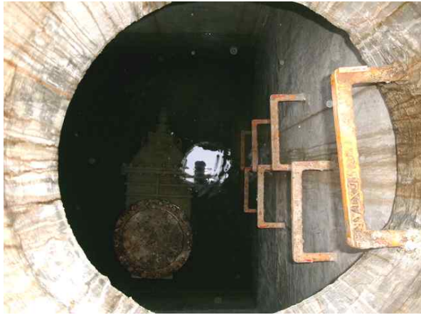
<송수관로 Sta.3+16.1(점검구) 밸브실 채수(H=0.3m)>
