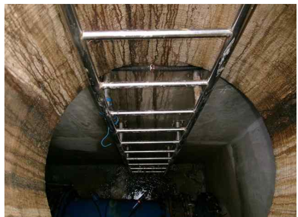
<송수관로 유량계실 사다리 설치 상태양호>
