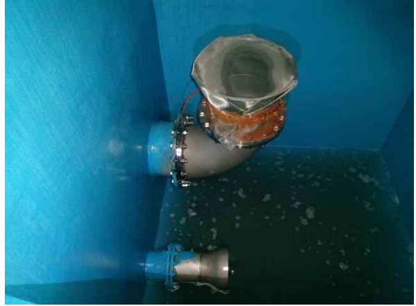
<2지 유출배관 상태양호>
