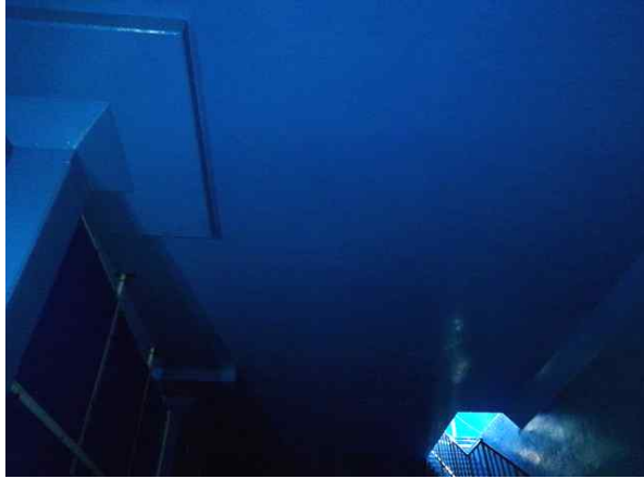
<배수지 2지 상부슬래브 상태양호>
