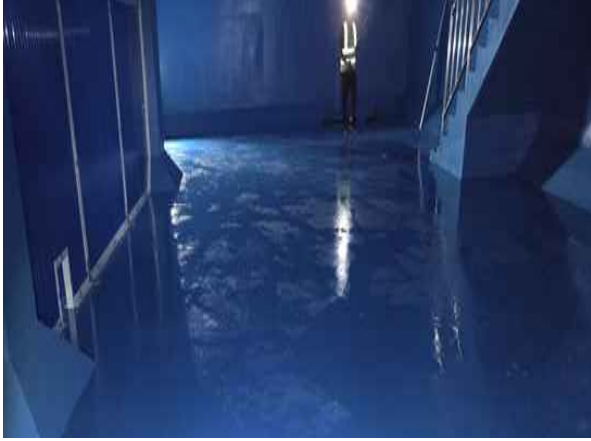
<내부 개별부재 외관조사>
