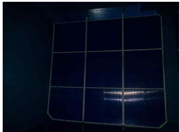
<배수지 1지 도류벽 상태양호>
