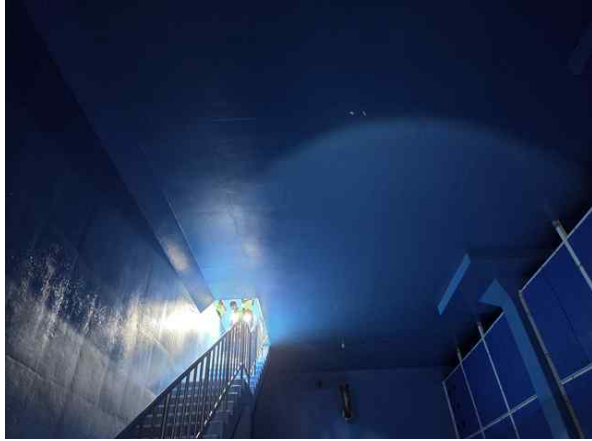
<배수지 1지 상부슬래브 상태양호>
