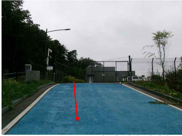
<송수관로 (Sta.1+9.0) 포장 및 지반 상태양호>
