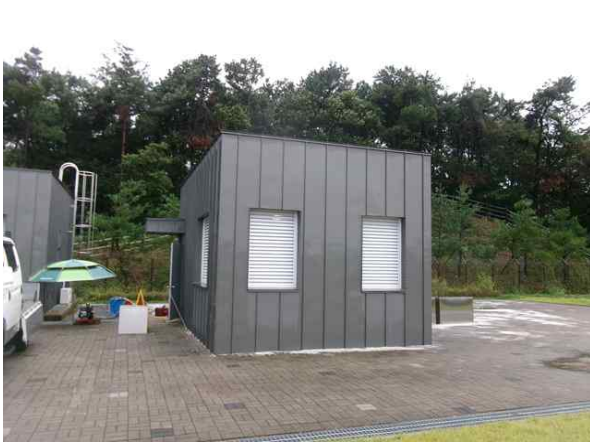
<전기실 외부 상태양호>
