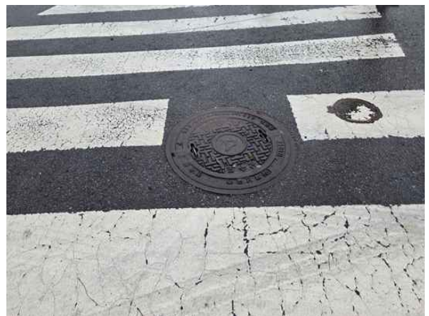
<송수관로 점검구(B1-2) 맨홀 덮개 상태양호>
