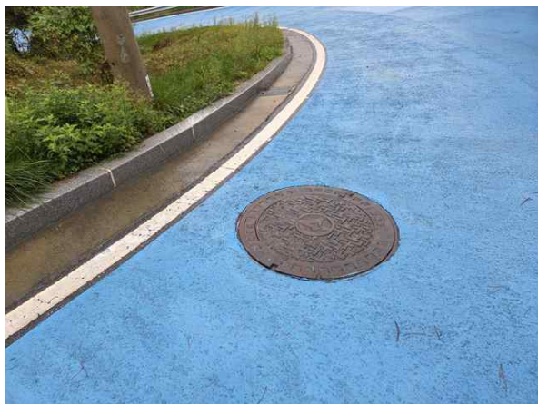
<송수관로 유량계실 맨홀 덮개 상태양호>
