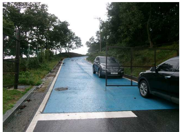
<송수관로 Sta.17+1.5 포장 상태양호>
