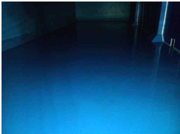
<배수지 2지 바닥슬래브 상태양호>
