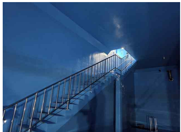
<배수지 1지 출입계단 및 안전난간 상태양호>
