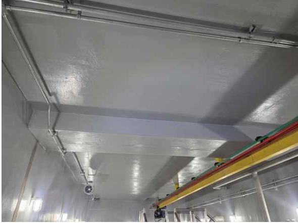
<유입밸브실 상부슬래브 상태양호>
