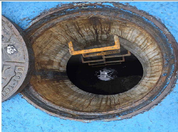
<송수관로 Sta.3+16.1(점검구) 점검사다리 상태양호>
