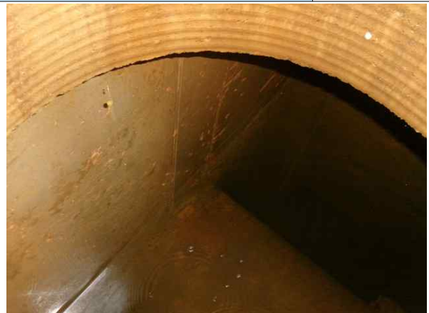
<송수관로 Sta.17+1.5(점검구) 벽체 상태양호>
